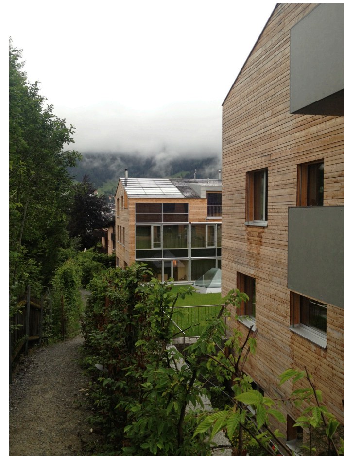
Westfassade Haus A, im Hintergrund Haus B
